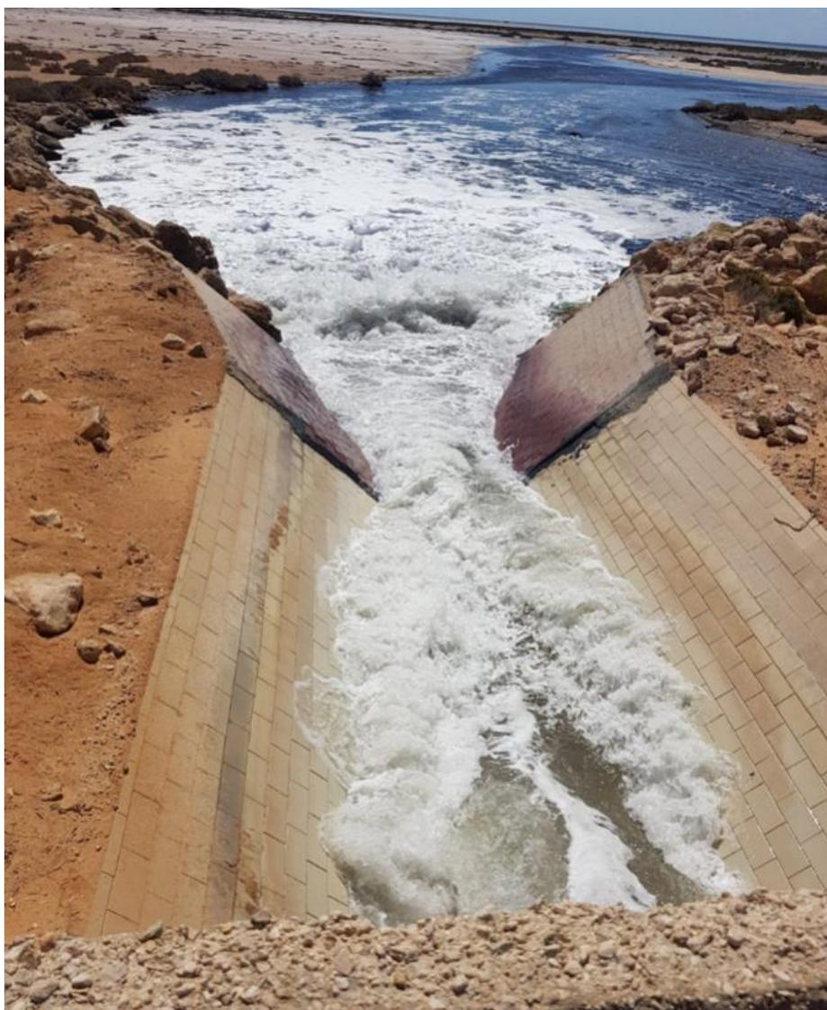
**Figure 6-16: Rejet hydrique de l'usine Skhira (Eau de refroidissement et de lavage)**
